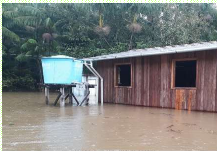
Figura 9: Monitoramento Cisterna Ilha de Papagaio. Foto: Paulo Melqui
